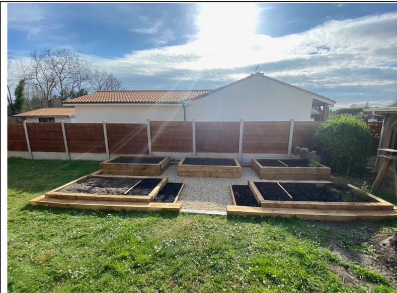
Exemple de réalisation d'un jardin en "carré" (en fait 3 rectangles de 210cmx100cm x40cm et 2 rectangles de 240cmx100cmx20cm) composé de traverses en bois (pin ou chêne) de dimensions 200x100mm assemblées avec des équerres galvanisées et posées sur un géotextile épais. L'entourage est fait avec une rangée de traverses, le petit gravier sert de finition pour le parterre. Le seuil est réalisé avec une barre d'ardoise recoupée à la dimension.
